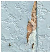
塗装が劣化し、雨水が塗膜と下地の間に侵入し溜まっています。見た目も悪く、下地の強度も低下するので早めの対策が必要です。
