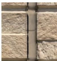
紫外線劣化によりコーキングに含まれる可塑剤が抜けるため、ひび割れや痩せ現象が発生します。そこから水が入り込み雨漏りの原因となりますので早めに対処しましょう。
