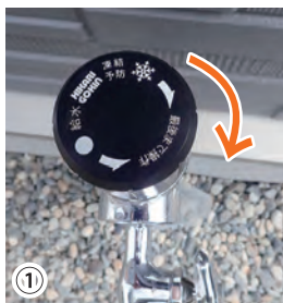
① 水抜栓を時計回りに回して水を抜く。
