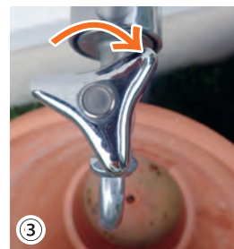
③ 吐水口から水の抜ける音がしなくなったら蛇口のハンドルを時計回りに回して閉める。
