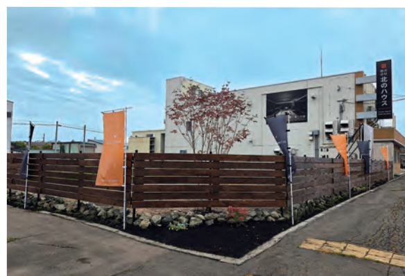
社屋の外構が完成
