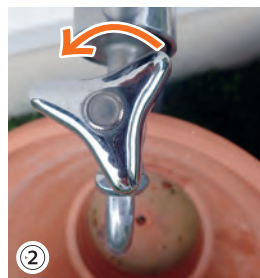
② 蛇口のハンドルを反時計回りに回して開け水を抜き2～3分待つ。
