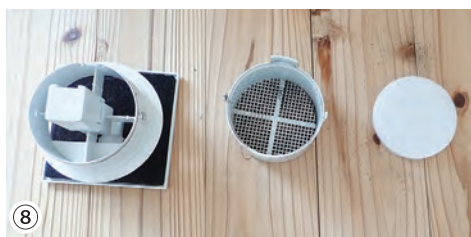
⑧ ①～⑥の逆の手順で戻して給気口へ取り付け完了です。
